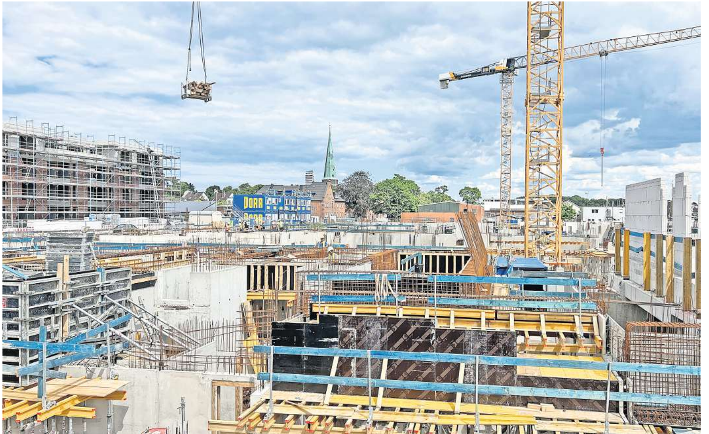
So sieht es jetzt auf der Baustelle des Baltique am Fischereihafen aus. Links das Gebäude, das am Baggersand entsteht. FOTOS: THOMAS KROHN
